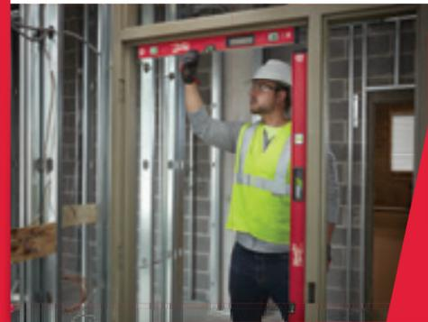
Armature en metal renforcé BACKBONE™. Corps plus résistant et durable. Système de réception de la fiole renforcé.
