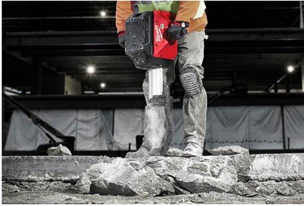
*Der Akku-Abbruchhammer liefert für anspruchsvolle Meißelarbeiten eine enorme Schlagenergie von 64 Joule. Mit einer Akkuladung können bis zu zwei Tonnen Beton abgebrochen werden.*
