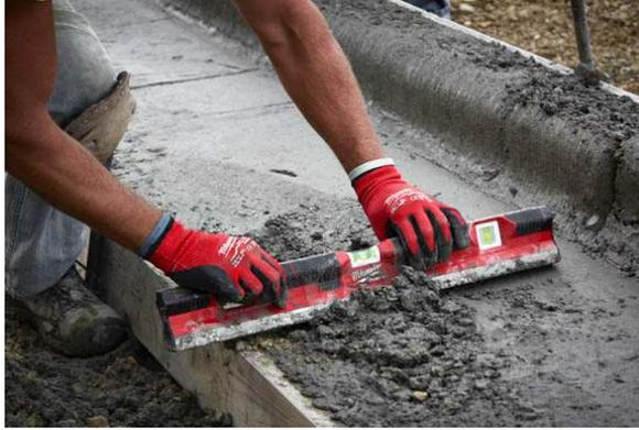
*Die REDSTICK Beton-Wasserwaagen sind leicht zu reinigen und besitzen eine deutlich breitere Magnesiumbasis zum Abziehen und Glätten von Estrich oder Beton.*
