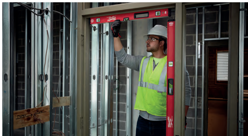
Zosilnené magnety zo vzácných zemín pre maximálnu silu (iba magnetické vodováhy).
